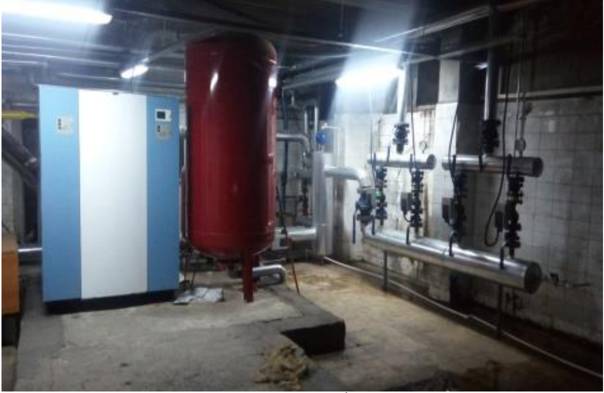
Süleyman Demirel Ortaokulu Doğalgaz Dönüşüm İşİ
