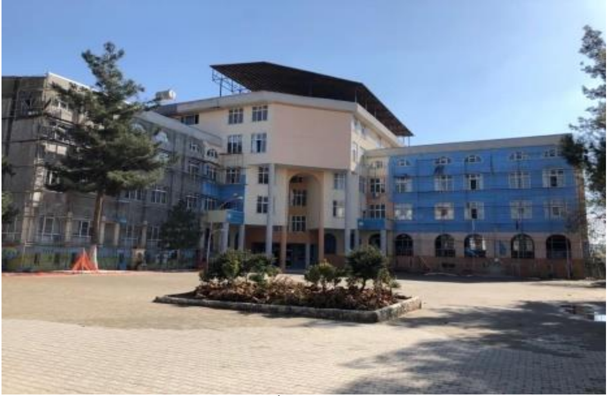
Merkez 15 Temmuz Ortaokulu Onarım İşi
